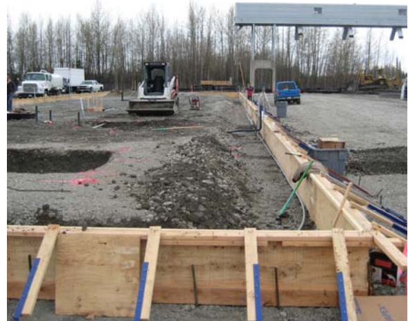
FRA Forming Foundation
